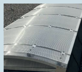
Tôle perforée fixée sur la voûte
