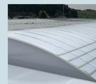
Bandes en aluminium fixées sur la voûte
