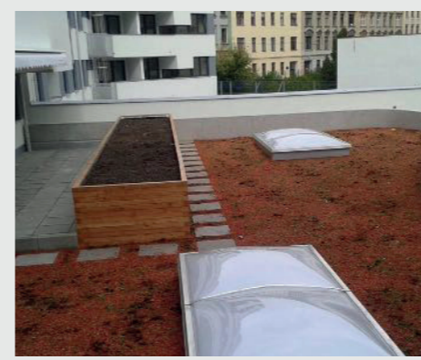
Immeuble d'habitation Valeur U de 1,1 à 0,8 W/m²K Coptole de 4 à 5 couches
